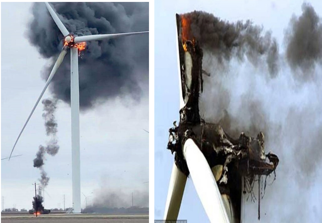
Рис.1. Поражение ветроагрегата молнией и пожар от удара молнии
